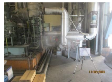
ชุด Steam Turbine Generator (Steam Turbine, Reduction Gear และ Generator)
